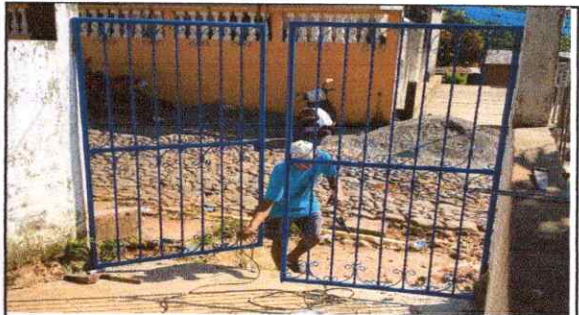
FOTO 10: Sustrucción de portón de metal
