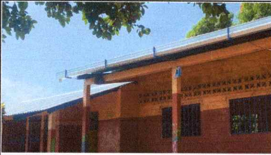
FOTO 9: Reparación de bajada de agua pluvial, tubo PVC 3"
