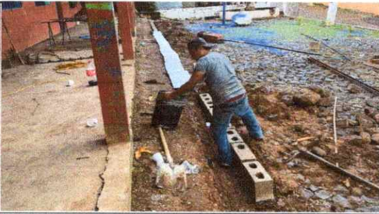
FOTO 11: Reparación de banquetas de concreto
