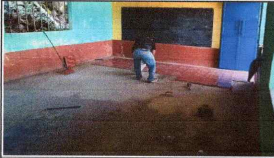
FOTO 7: Sustrucción de piso de cemento liquido por piso ceramico
